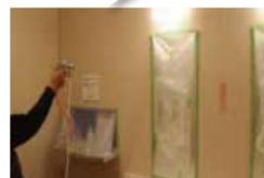
寝室・子供部屋・リビング等のサッシガラス面にプラチナチタン触媒「エアプロット」を塗布いたします。ガラス面に塗布したプラチナチタン触媒コーティングは空気中の汚れやニオイを分解しますのでガラス面の拭き掃除は半年に1回の実施でキレイを維持します。
